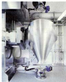
Im ersten Obergeschoss des neuen Gebäudes wird gemischt.
